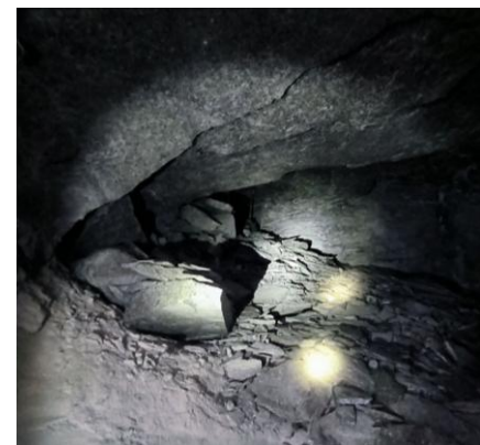
Фиксация нарушений в элементах отработки
